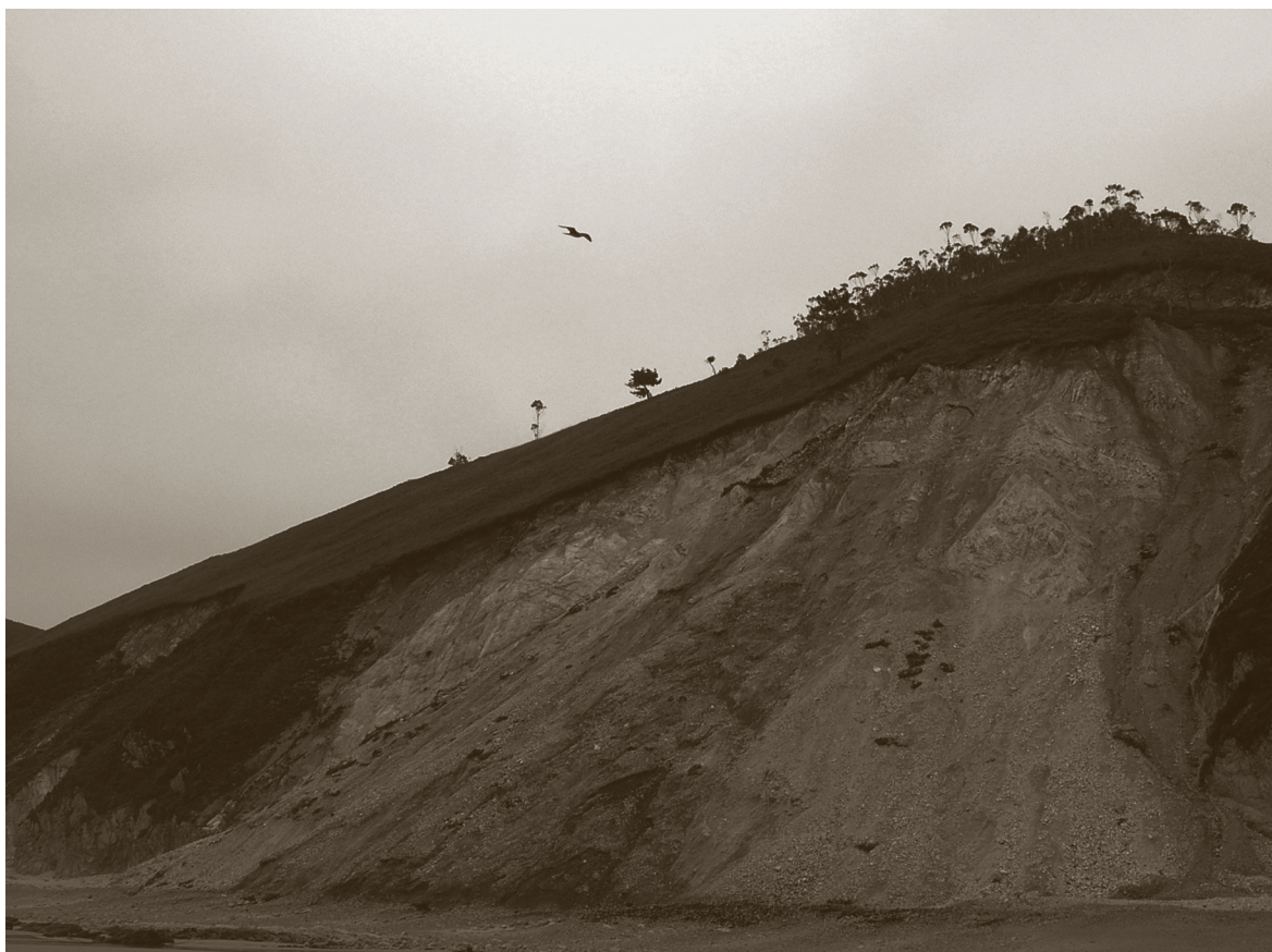
Vista general del argayu . Se aprecian en primer término los materiales derrumbados sobre la playa y en la parte superior, la fracción semidesmoronada de la Cuesta de Bricia (Foto Luis Carrera).
