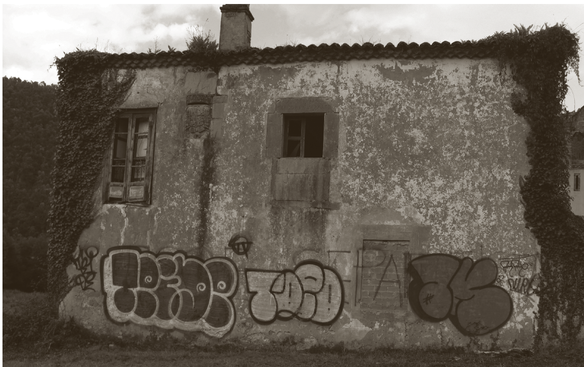
Pintadas en los edificios de San Antolín de Bedón (Foto Juan Carlos Villaverde).
