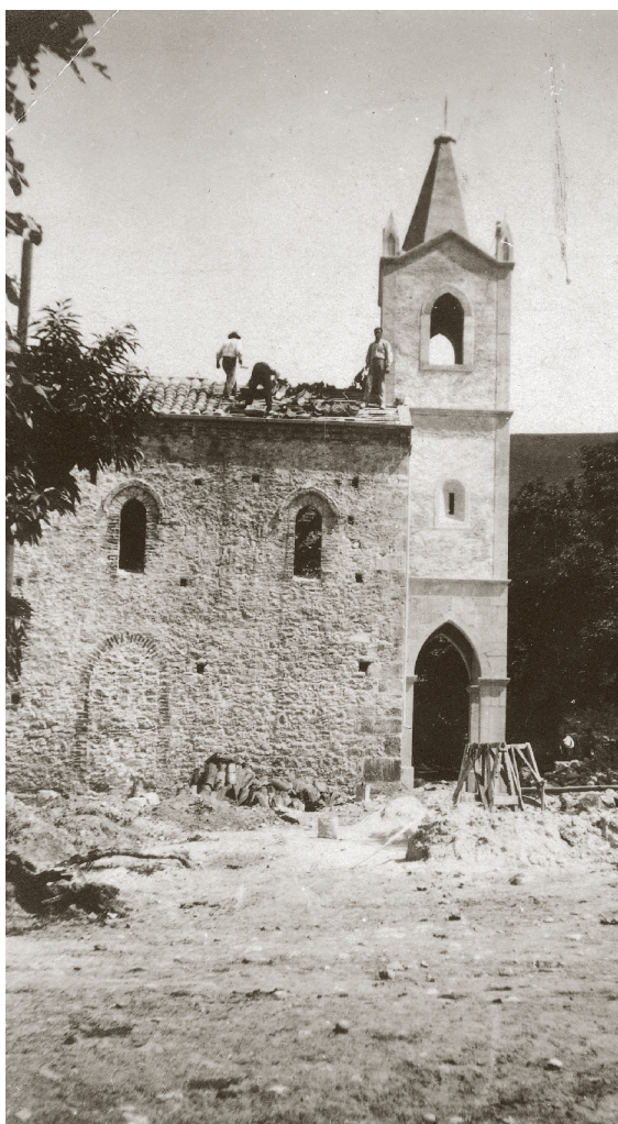
Rematando el tejado de la iglesia con la torre ya construida.
