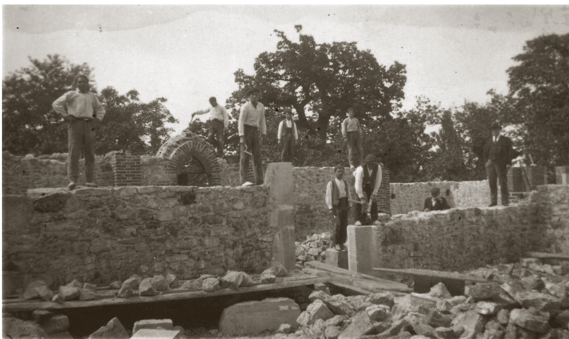
Levantamiento de los muros de la nueva iglesia de Naves ( Foto atribuible a Benigno del Cueto ).
