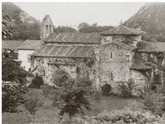
La colonia escolar tenía su sede en las casas anexas a la iglesia de San Antolín de Bedón.
