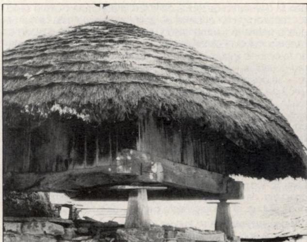
Horreo con cubierta de paja colocada a **baguna**, es decir, con los haces sujetos por el exterior con un trenzado de varas.
