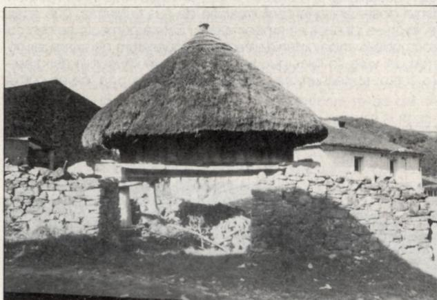
Horreo con cubierta de paja a **paleta**, o sea, atada por el interior a la armadura de madera.
