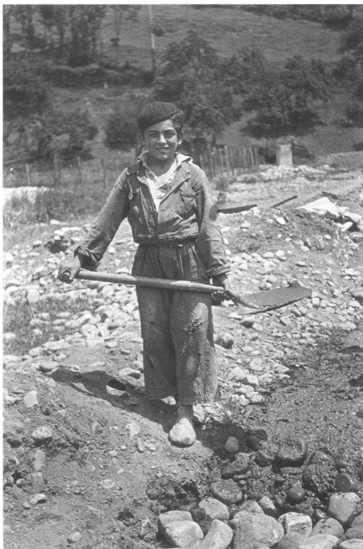
Peón de la construcción (Laviana, 1945).
