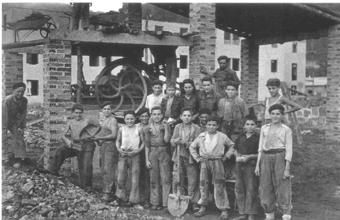
Construcción de las casas del Serrallo (Sotrondio, 1946).
