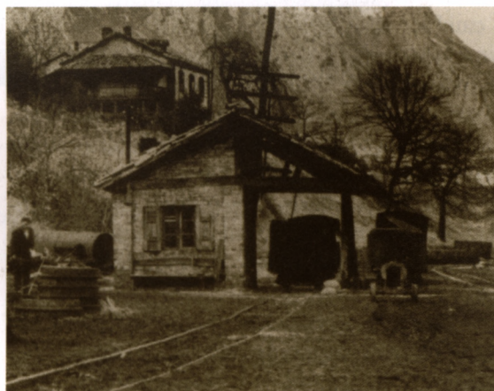
ANÓNIMO. Estación del ferrocarril (La Fábrica).
